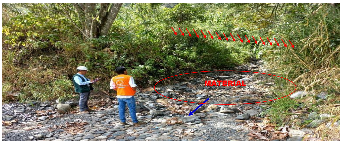
FIGURA N°03: PROFESIONAL DE LA ALA LA CONVENCION OBSERVA EL MATERIAL COLMATADO EN EL CAUCE DE LA QUEBRADA, CON UNA PROFUNDIDAD PROMEDIO DE 0.50 M Y CUBIERTO DE VEGETACION DE LA ZONA. ESTO PROVOCA QUE DESBORDAMIENTO DEL RÍO SEA MAS INMINENTE.
